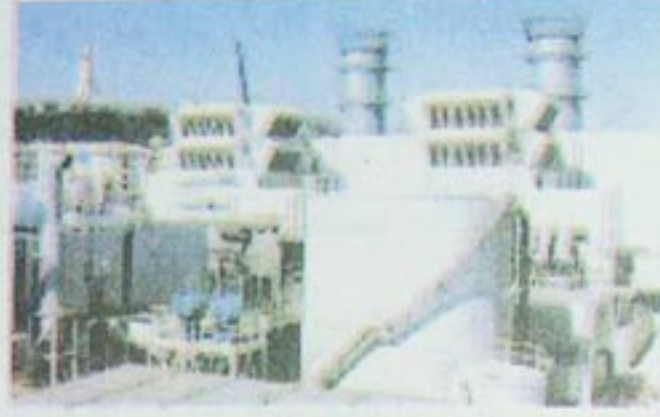
محطة توليد الكهرباء
